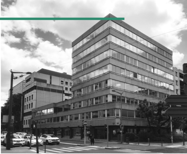
Existant Vue depuis l'angle des rues Servient & A. Philip
