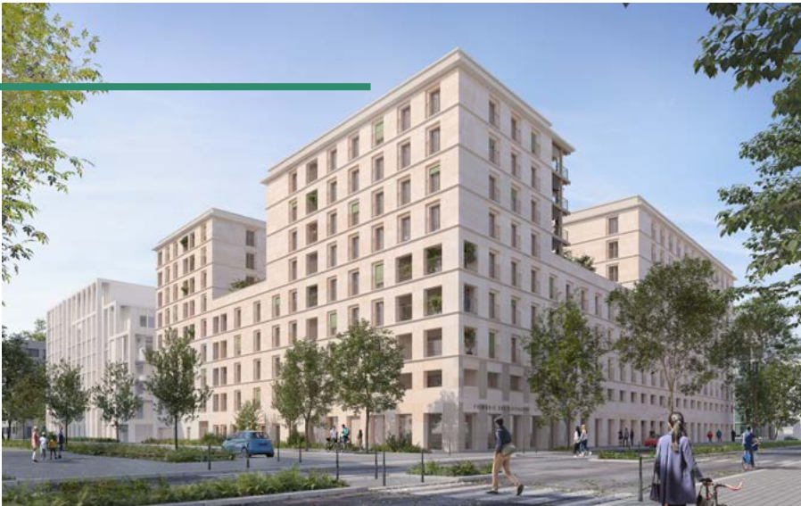
Vue depuis l'angle des rues Simone de Beauvoir & des Girondins
