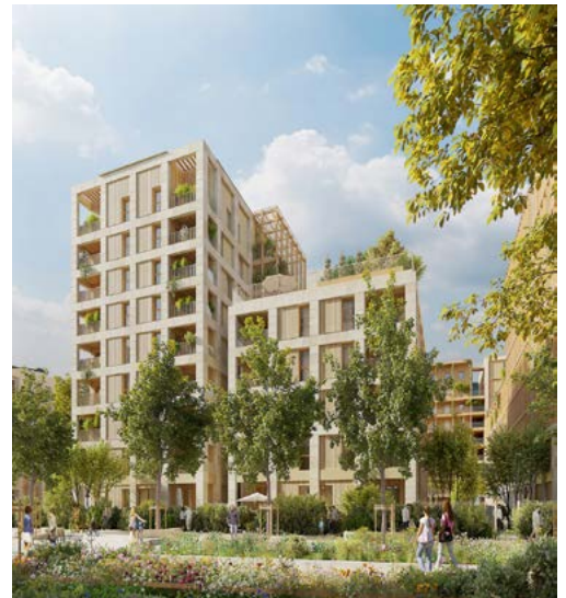
Vue sur bâtiment D depuis allée Senghor
